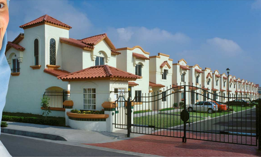
Comunidad de vivienda de interés social Zona Metropolitana de la Cd. de México
